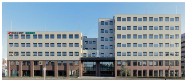
写真2 新経済センタービル北面
